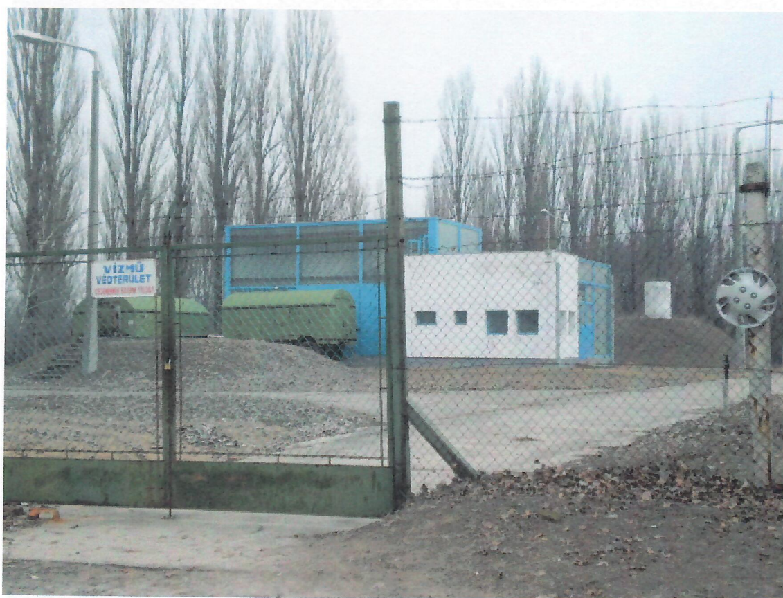
11. számú kép. Szivattyútelep
